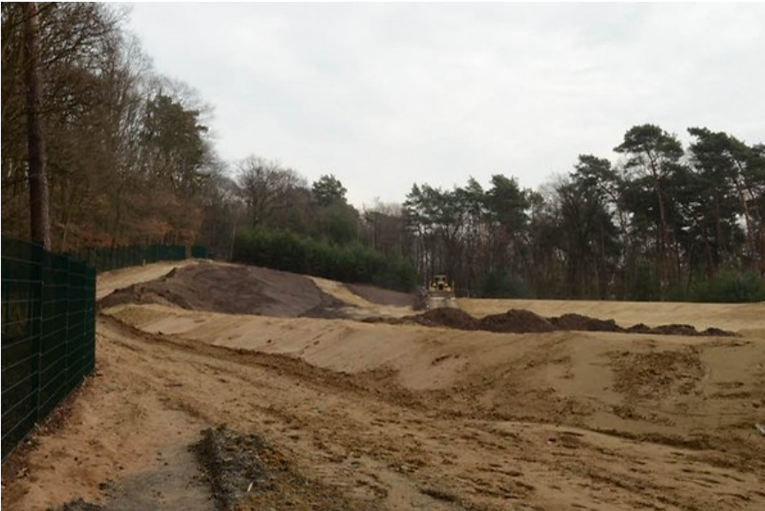
Am neuen Regenrückhaltebecken Ost werden Wanderweg und Zaun verlegt, wie Dennis Stegmann (hinten) und Dietmar Andresen erläuterten.
