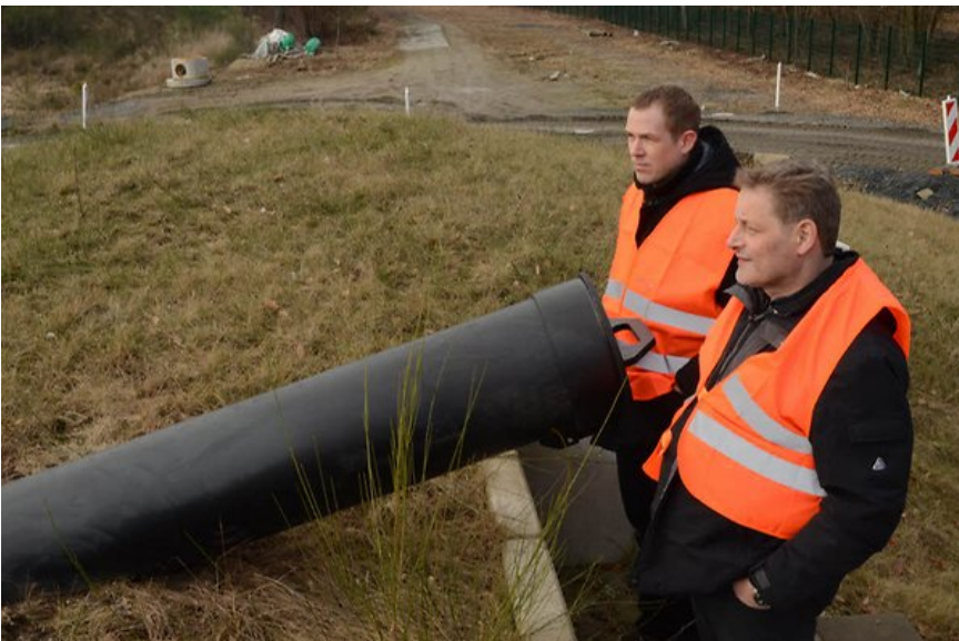
Am neuen Regenrückhaltebecken Ost werden Wanderweg und Zaun verlegt, wie Dennis Stegmann (hinten) und Dietmar Andresen erläuterten.
